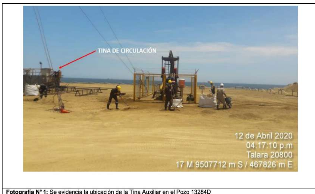
Fotografía N° 1: Se evidencia la ubicación de la Tina Auxiliar en el Pozo 13284D
