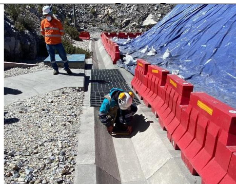
Fotografía 4. Se observa que el perímetro de la plataforma Marshalling 2 está conformada por una canaleta de concreto de dimensiones: 0,30 metros de ancho inferior, 0,90 metros de ancho superior, y altura de 0,35 metros. Fuente: Recorte del archivo IMG_0119.
