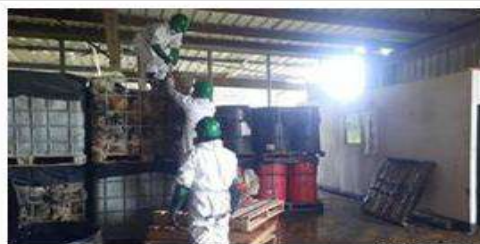
Acondicionamiento de residuos Almacén López. Coordenadas UTM WGS84 375551 E /9713271N 10 de marzo de 2021
