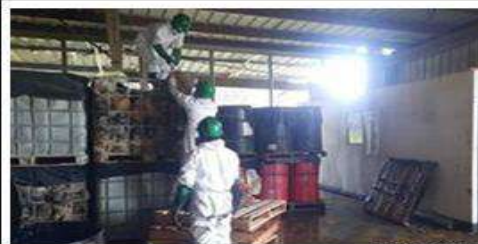
Acondicionamiento de residuos Almacén López. Coordenadas UTM WGS84 375551 E /9713271N 10 de marzo de 2021
