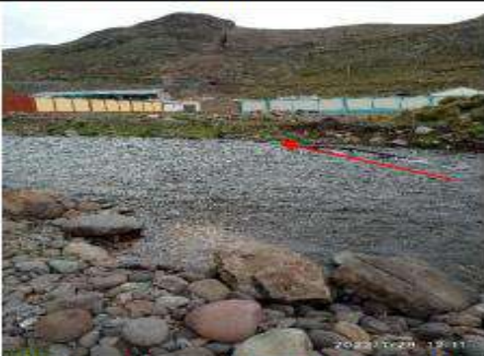
FOTOGRAFÍA N° 66.- (IMG_20220128_121116) Vista de la tubería que cruza el río Paratía con dirección al sistema de tratamiento SMA-01
