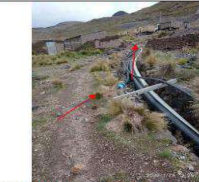
FOTOGRAFÍA N° 68.- (IMG_20220128_122512) vista de la tubería llegando al canal, luego esta sigue visible hasta llegar a la bocamina
