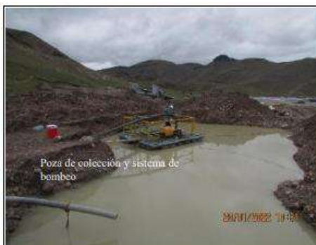
FOTOGRAFÍA N° 62.- (IMG_8765) Vista del sistema de bombeo desde la poza de colección del depósito de relave
