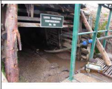
FOTOGRAFÍA N° 69.- (IMG_8861) Vista de la tubería HDPE ingresando a la bocamina
