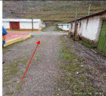
FOTOGRAFÍA N° 67.- (IMG_20220128_122345) Vista de la calle por donde la tubería HDPE se encuentra enterrada
