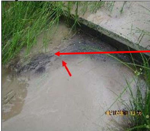
Foto N° 9: Agua superficial con presencia de material oleoso con característica similar a hidrocarburo, que se encontraron contenidos en una madera que cruza el flujo de agua.
