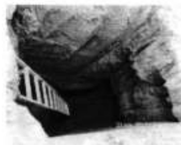
Foto 3. A 3 a 4 m profundidad de calicata, ausencia de agua freática.
