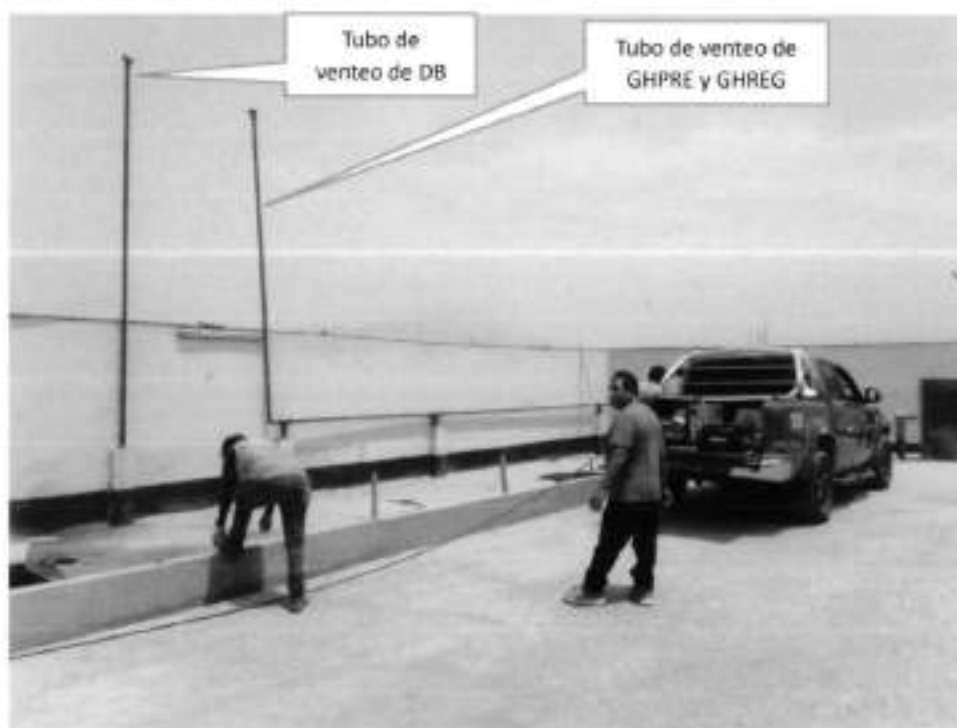
Foto N° 01: Vista de la Zona de Tanques de almacenamiento de combustibles, donde se verifica la conexión de los tubos de venteo, distinto a lo aprobado en EIA.
