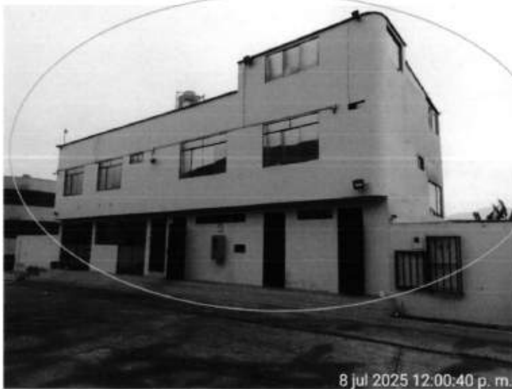
Foto N° 07: Vista de la edificación N° 1; Cuenta de dos niveles y una azotea. El área ocupada por la edificación es una ampliación del área de la unidad (Área ocupada por la edificación es un área de ampliación).
