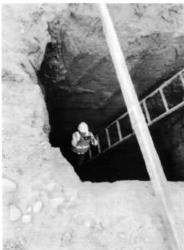
Foto 4: Base de la calicata a 4.0 m - sin presencia de agua libre
