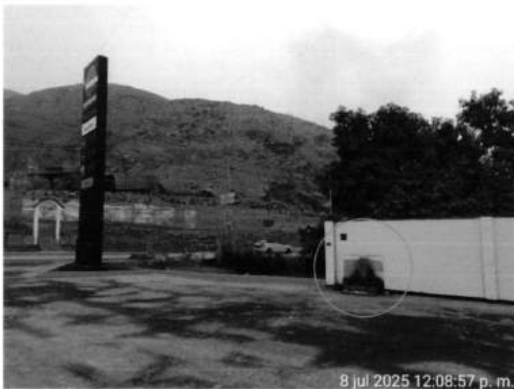
Foto N° 08: Vista de la nueva ubicación del punto de agua para vehículos. Se ubica en patio de maniobra zona salida a la Carretera Lima Canta.
