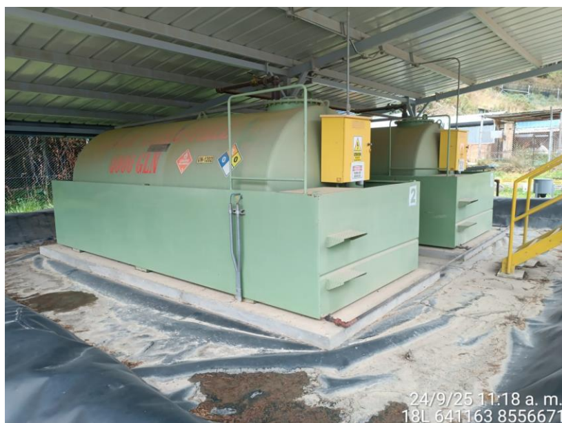
Fotografía 5-1 Vista lateral de la Estación de Abastecimiento Temporal
