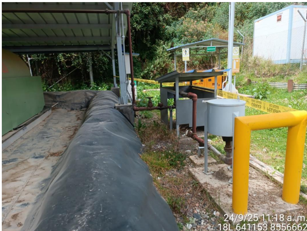
Fotografía 5-3 Vista de uno de los tanques de la Estación de Abastecimiento Temporal donde se puede visualizar la poza de contención cubierta por la geomembrana HDPE y el techo
