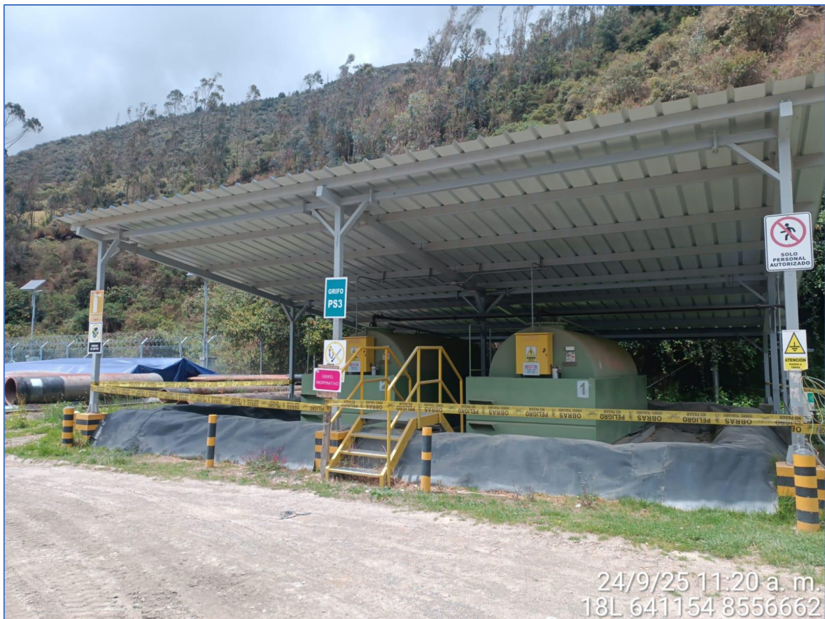
Fotografía 2-1 Vista frontal de la situación actual de la Estación de Servicio Temporal
