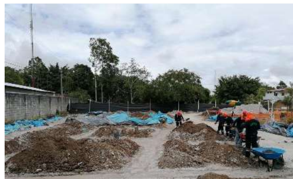
Imagen 1. Proyecto en ejecución
