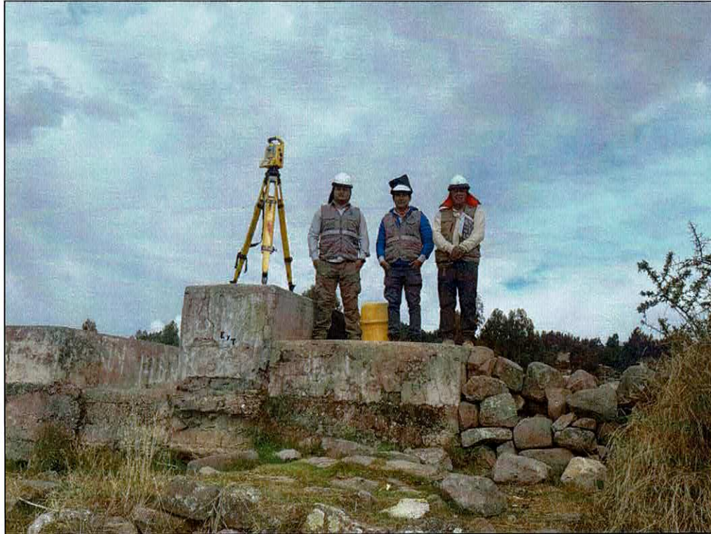
FOTOGRAFIA N°27.- Esta supervisión verifica los trabajos de trazo y replanteo de acuerdo a lo indicado a las especificaciones técnicas del expediente técnica.
