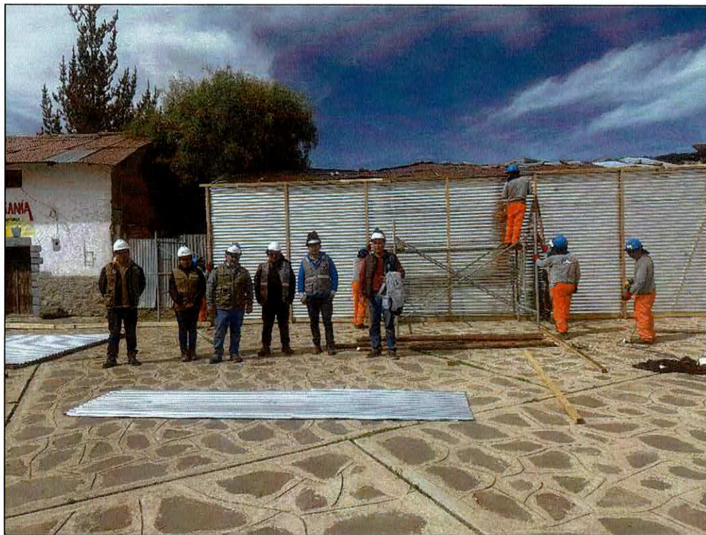
FOTOGRAFIA N°05.- Se continua con las coordinaciones de obra con el residente y el plantel técnico, verificando los trabajos de cerco provisional que estas cumplan de acuerdo a lo indicado en las especificaciones técnicas del expediente técnico.
