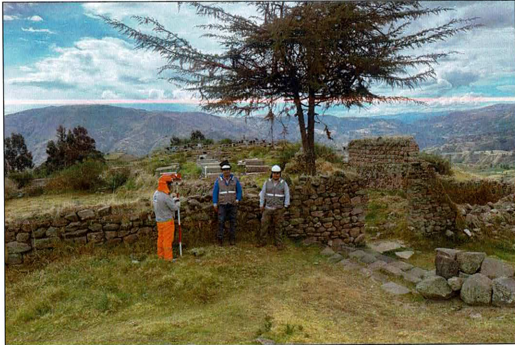
FOTOGRAFIA N°28.- Esta supervisión verifica los trabajos de trazo y replanteo de acuerdo a lo indicado a las especificaciones técnicas del expediente técnica.
