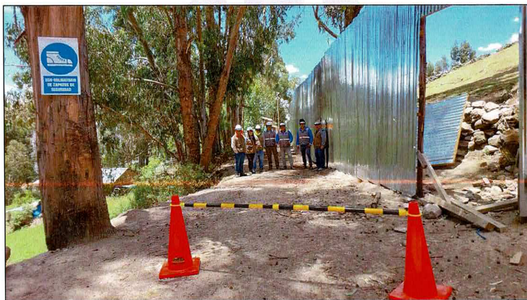
FOTOGRAFIA N°22.- Se continua con las debidas inspecciones en obra verificando los procesos constructivos de obra y que estas se encuentren totalmente señalizadas.
