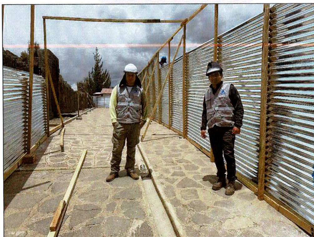
FOTOGRAFIA N°12.- Se tiene coordinación constante con el especialista de seguridad verificando que todo el personal cuente con sus respectivos implementos de seguridad.
