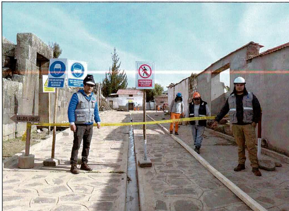
FOTOGRAFIA N°10.- Esta supervisión verifica la correcta señalización en obra además que todo el personal se encuentre correctamente implementados con sus equipos de protección personal.
