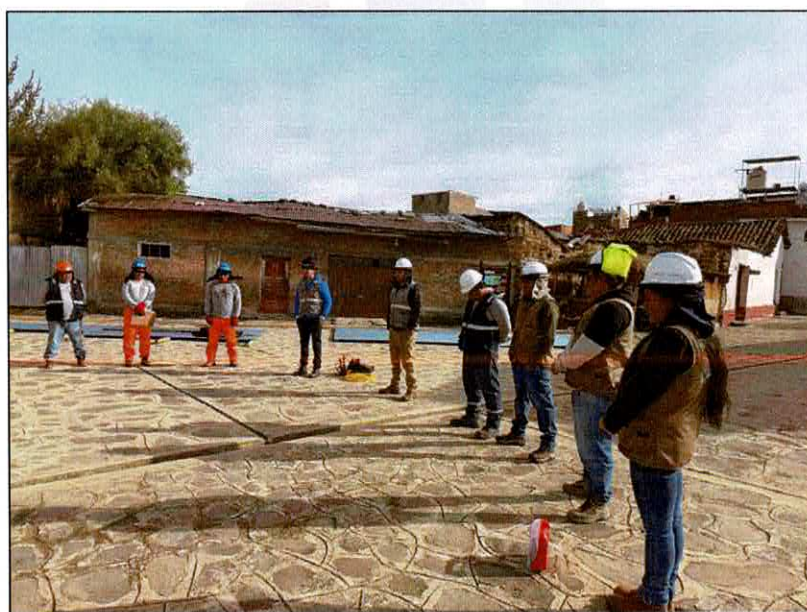
FOTOGRAFIA N°26.- Esta supervisión verifica y participa en las charlas de inducción antes del inicio de la jornada laboral realizado por los especialistas de seguridad y con la participación de todo el personal de trabajo.
