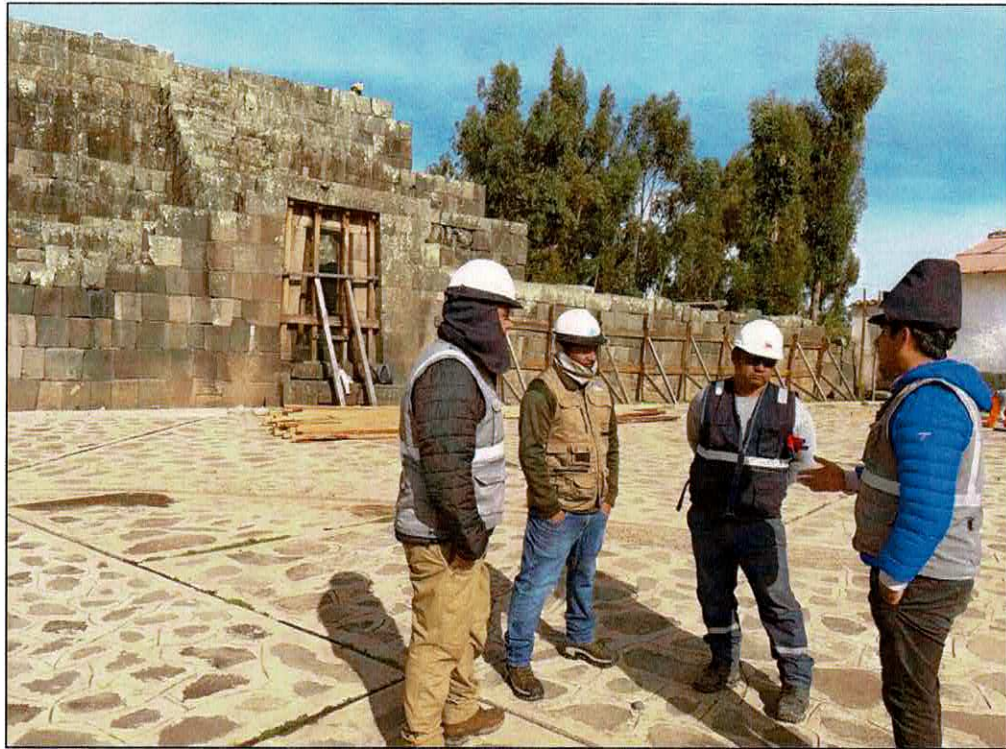
FOTOGRAFIA N°09.- Se continua con las coordinaciones con el maestro de obra respecto a los trabajos a realizar del cerco perimétrico.
