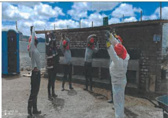
Fotografía N° 005: verificación de pausas activas en los frentes de trabajo
