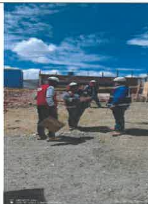
Fotografía N° 006: Verificación del llenado de ATS, Check list.
