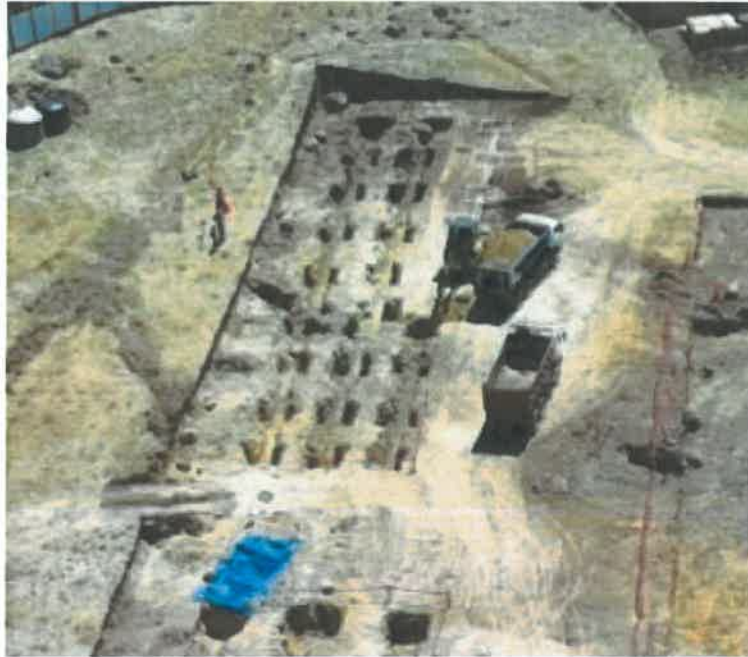
FOTO N°01: SE REALIZO LA EXCAVACION EN LOS BLOQUES
