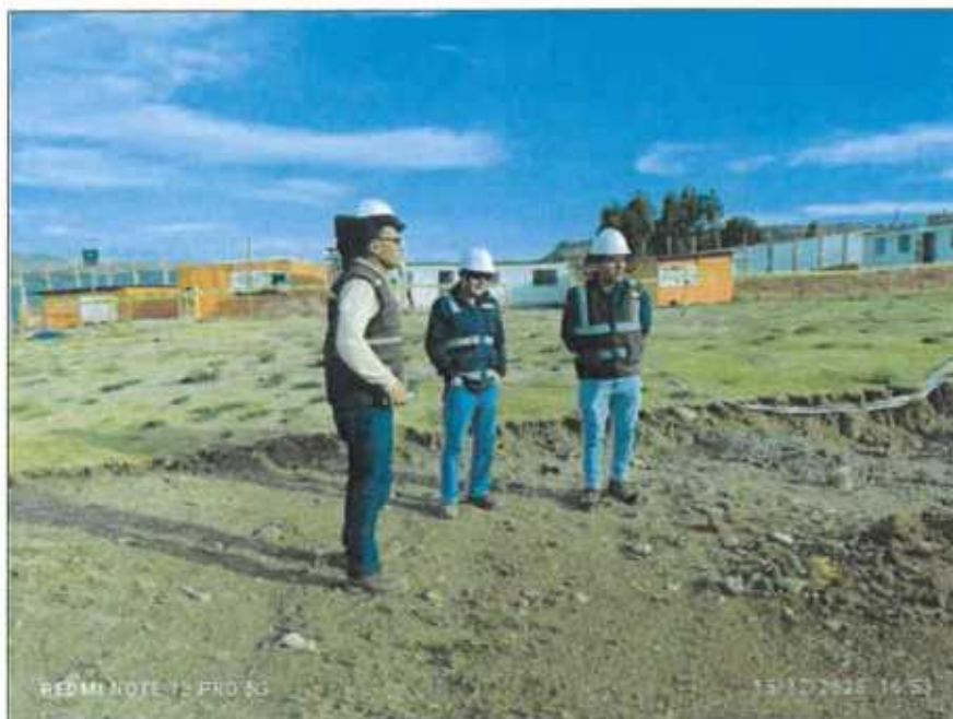
FOTO N°03: COORDINACION CON LA RESIDENCIA DE OBRA, RESPECTO A LA ACTIVIDAD DE CORTE MASIVO
