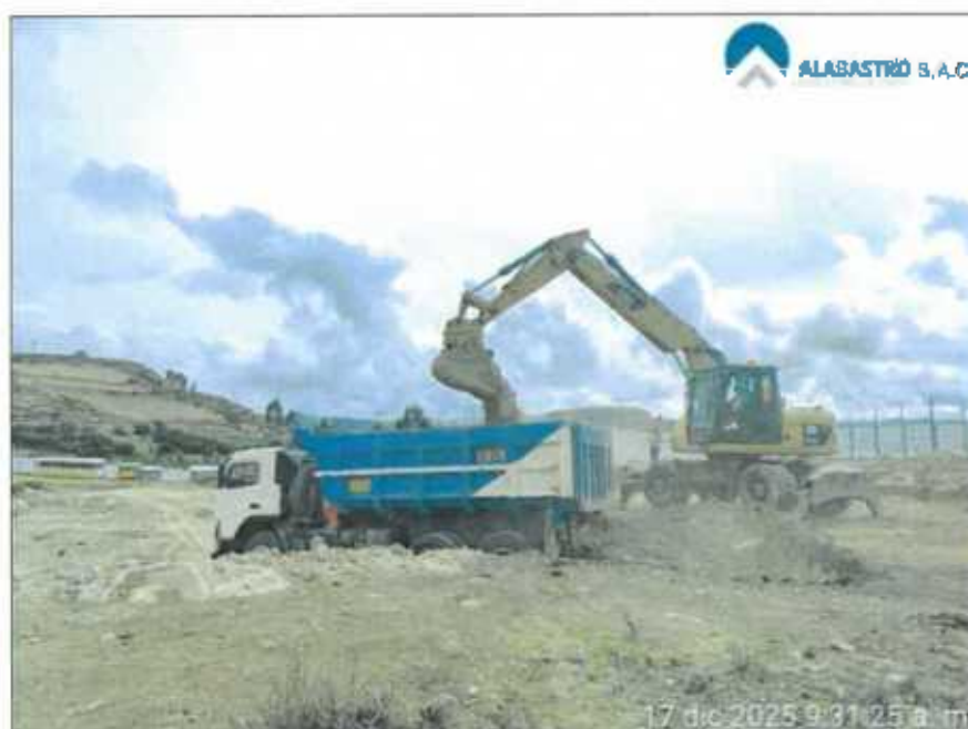
FOTO N°04: EJECUCION DE EXCAVACION MASIVA PERTENECIENTE AL ADIC. N°01
