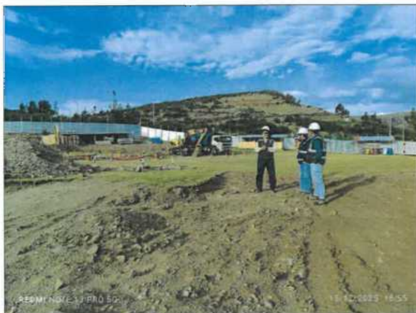
FOTO N°02: COORDINACION CON LA RESIDENCIA DE OBRA, RESPECTO A LA ACTIVIDAD DE CORTE MASIVO
