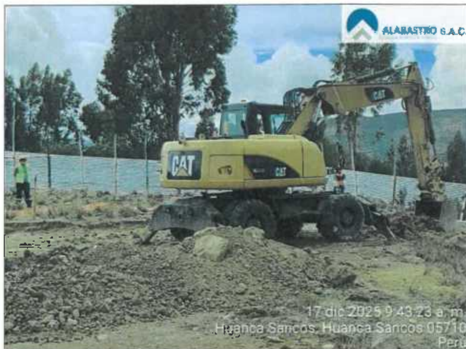
FOTO N°05: EJECUCION DE EXCAVACION MASIVA PERTENECIENTE AL ADIC. N°01
