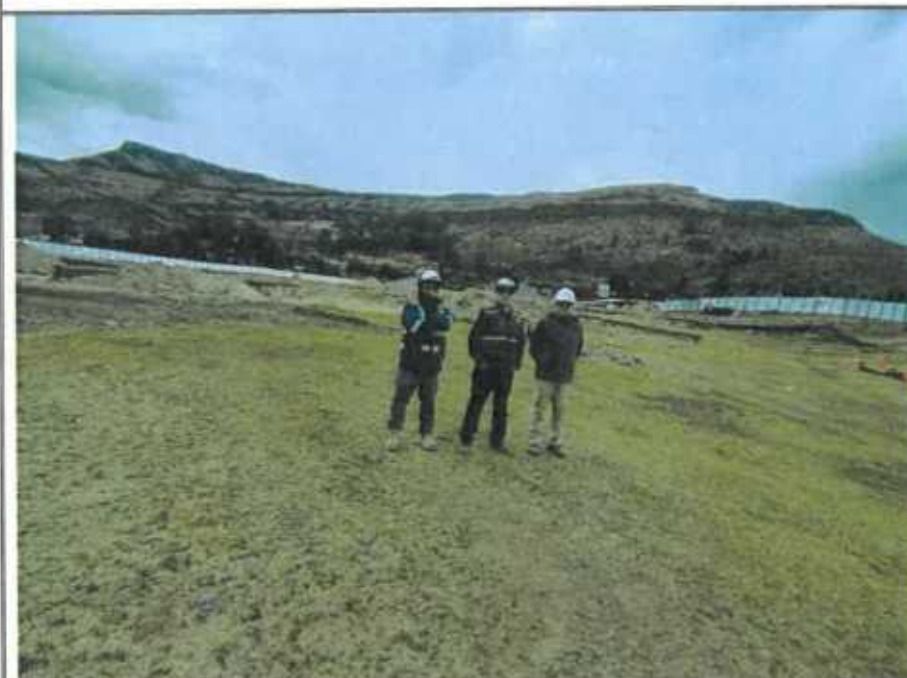
VISTA N°4: Coordinaciones en obra, juntamente con el equipo de especialistas de la Supervisión (11 de diciembre de 2025).
