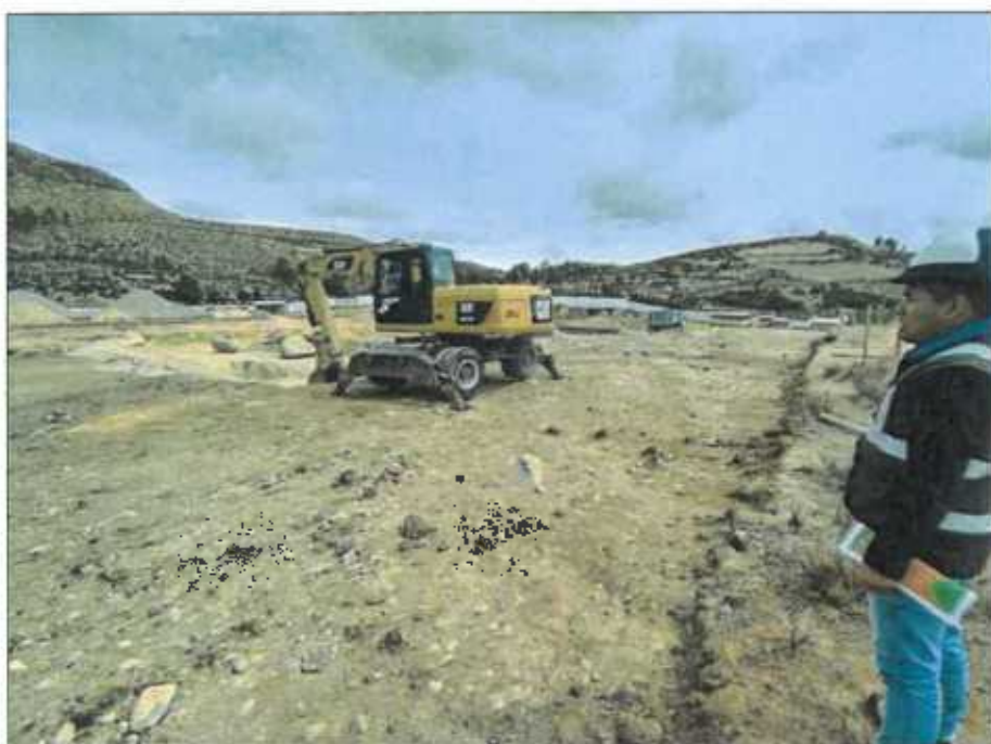
FOTO N°08: VERIFICACION DE NIVELES PARA EXCAVACION DEL EXPEDIENTE ADIC. N°01
