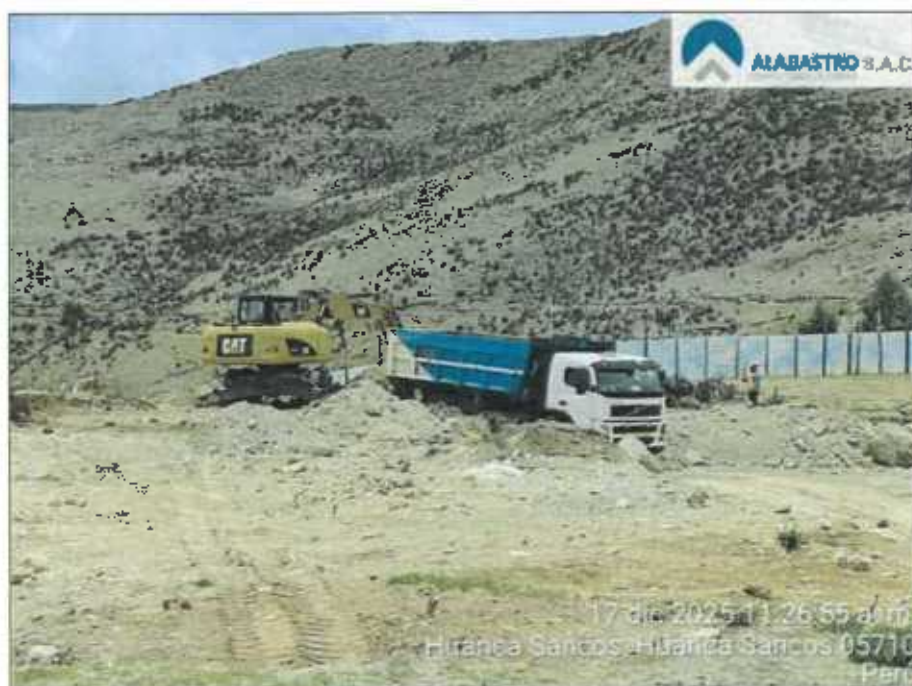
FOTO N°06: VERIFICACION DE EXCAVACION PARA ZAPATAS
