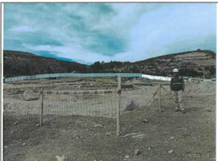
VISTA N°1: Visita a obra (10 de diciembre de 2025)
