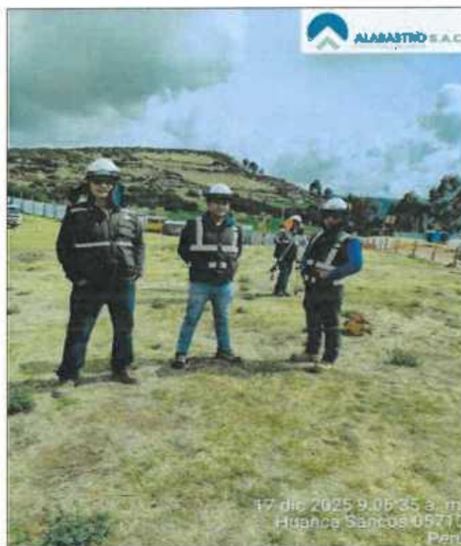
FOTO N°01: PRESENCIA DE LA SUPERVISION PARA LA VERIFICACION DE NIVELES DE EXCAVACION
