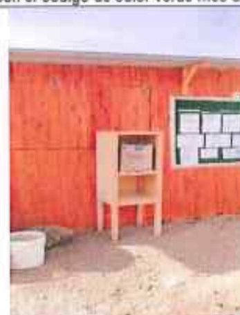
Fotografía N° 018: Verificación del punto de Hidratación.
