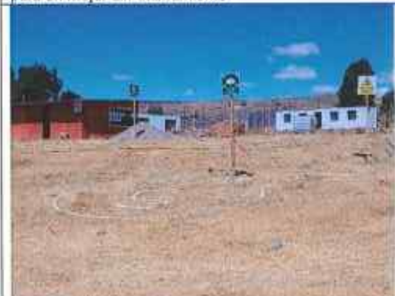
Fotografía N° 029: verificación de las señalizaciones.
