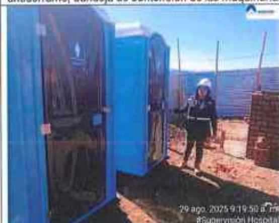
Fotografía N° 009: verificación de la limpieza de los servicios higiénicos
