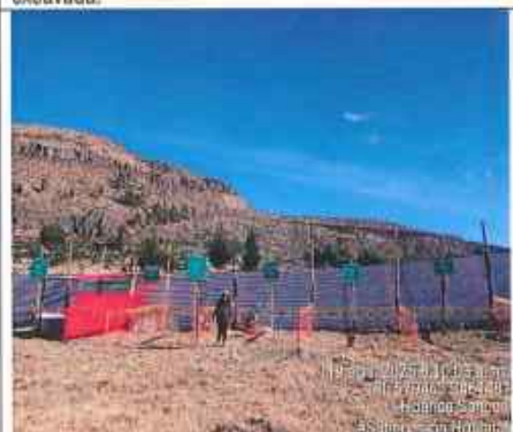
Fotografía N° 027: verificación del acopio temporal de RR.SS. de construcción quedando pendiente el techo para un mejor almacenamiento
