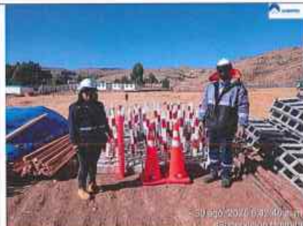
Fotografía N° 010: Verificación de las Protecciones Colectivas
