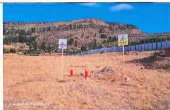
Fotografía N° 026: observación levantada señalización adecuada
