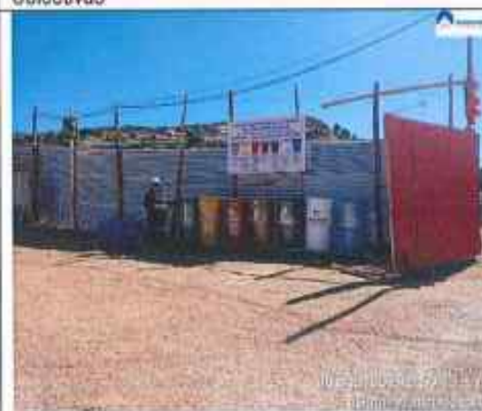
Fotografía N° 012: Verificación de segregación de RR. SS
