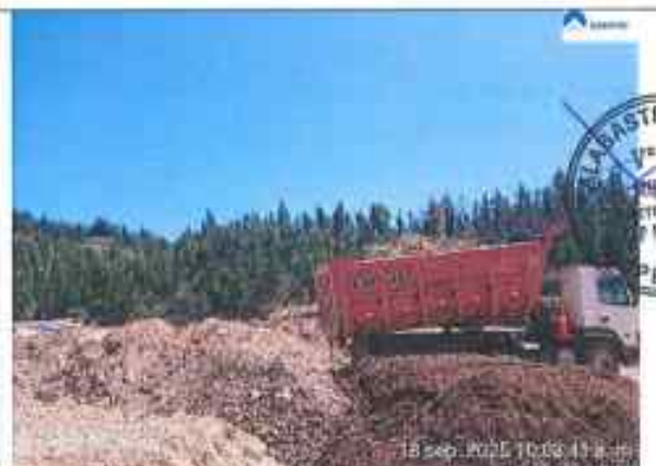
Fotografía N° 030: verificación de la eliminación de material excedente el depósito autorizado por la Municipalidad Provincial de Huancasancos.
