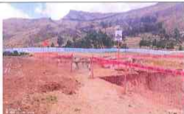
Fotografía N° 026: observación levantada señalización adecuada
