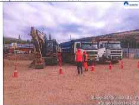
Fotografía N° 015: verificación del llenado de ATS, Inspección Preoperacional de vehículos
