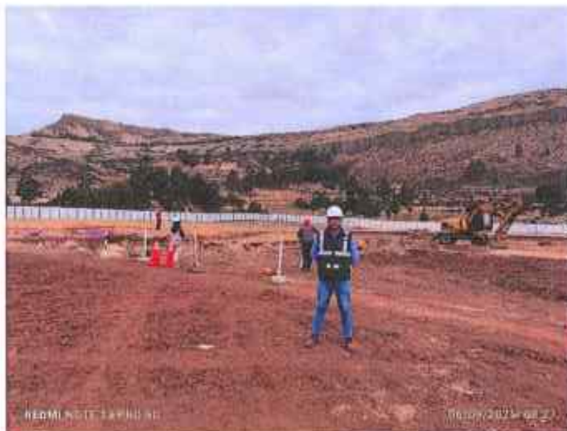
FOTO N°08: VERIFICACION DE EXCAVACION PARA ZAPATAS
