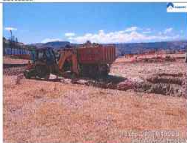
Fotografía N° 028: verificación del carguo de material excedente
