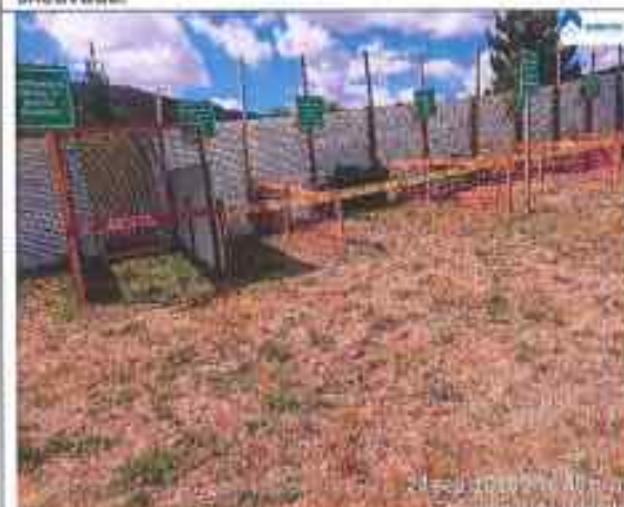
Fotografía N° 027: verificación del acopio temporal de RR.SS de construcción quedando pendiente el techo para un mejor almacenamiento
