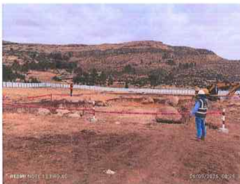
FOTO N°08: VERIFICACION DE EXCAVACION PARA ZAPATAS
