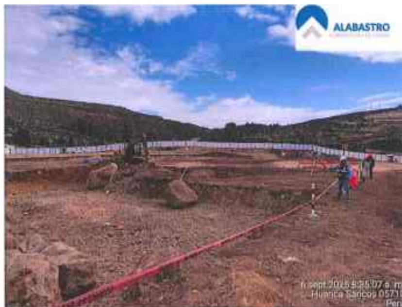
FOTO N°07: VERIFICACION DE EXCAVACION PARA ZAPATAS
