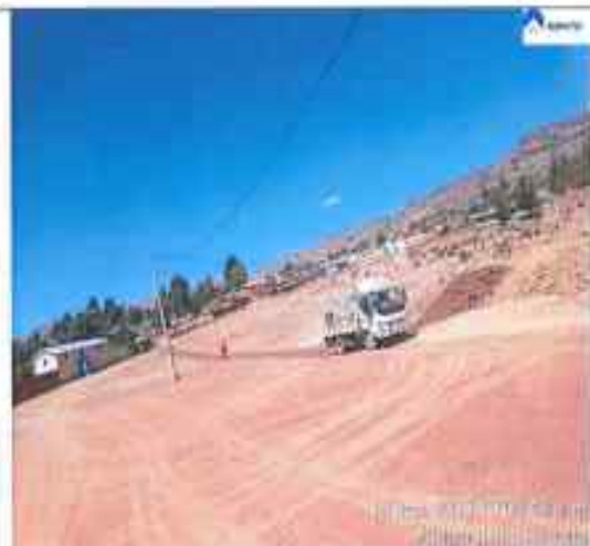
Fotografía N° 013: verificación de riego en las vías del depósito de material excedente.
