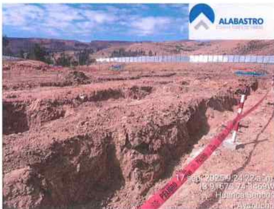
FOTO N°10: VERIFICACION DE EXCAVACION PARA ZAPATAS
