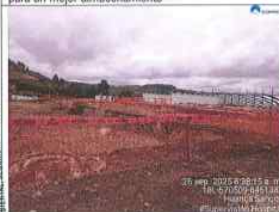
Fotografía N° 029: verificación de las señalizaciones.
