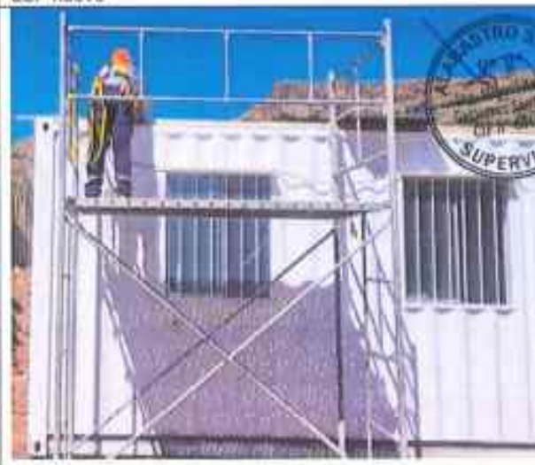
Fotografía N° 024: observación levantada uso de arnes adecuada.
