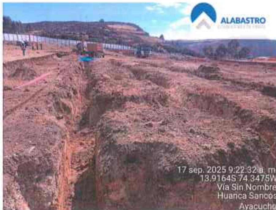
FOTO N°12: VERIFICACION DE EXCAVACION PARA ZAPATAS
