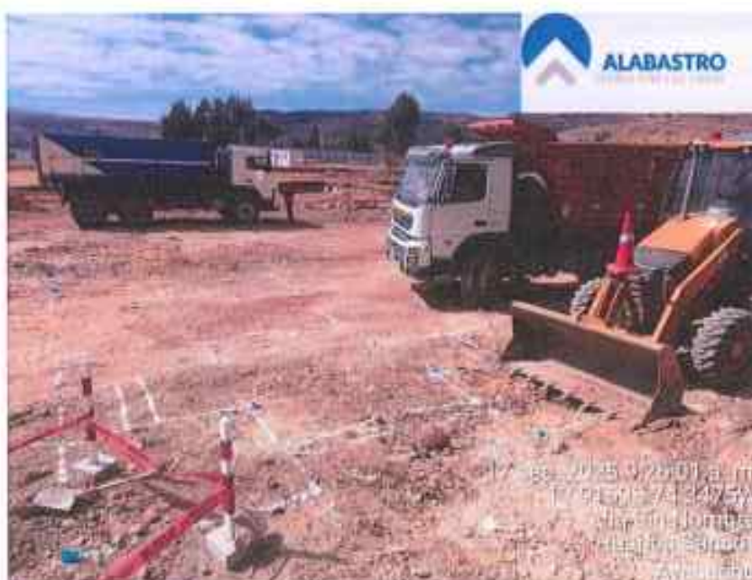
FOTO N°09: TRAZO PARA EXCAVACION DE ZAPATAS
