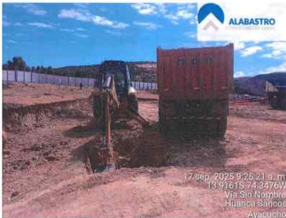
FOTO N°09: VERIFICACION DE EXCAVACION PARA ZAPATAS
