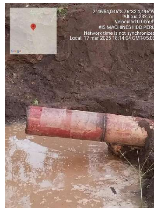
En la imagen se aprecia el ciego temporal, instalado en el extremo del tramo fuera de servicio en el km 11 del Ramal Norte del Oleoducto Norperuano. Fotografía tomada el 17 de marzo de 2025.
