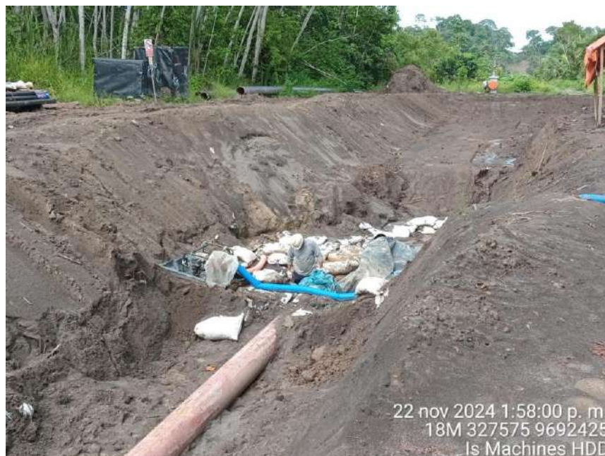
Vista de zanja excavada donde se aprecia parte de la tubería de 16" (570 m) a abandonar del Ramal Norte del Oleoducto Norperuano. Fotografía tomada el 22 de noviembre de 2024.
