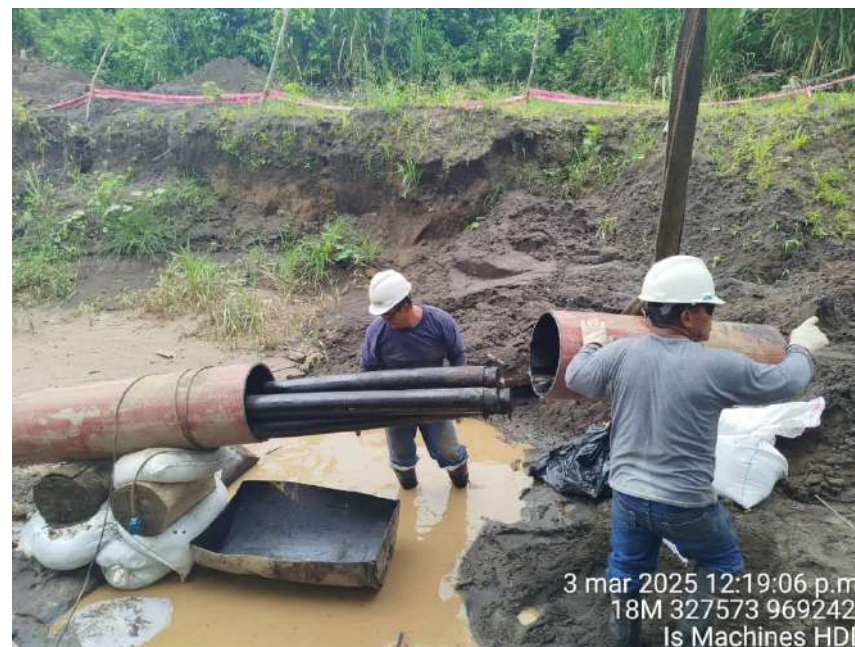
Se aprecia parte de la tubería de 16" (570 m) a abandonar del Ramal Norte del Oleoducto Norperuano. Se aprecia la distribución interna de la tubería. Fotografía tomada el 3 de marzo de 2025.
